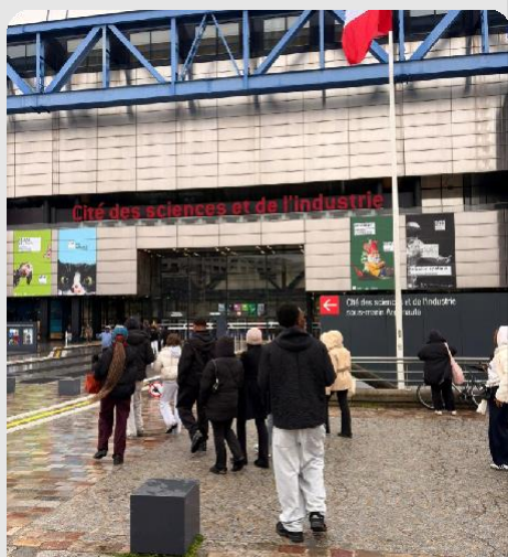
Façade de la Cité des Sciences
